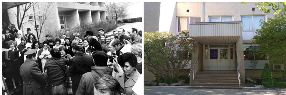
Рис. 18. Крыльцо главного входа в гостиницу в 80-е годы и сейчас
